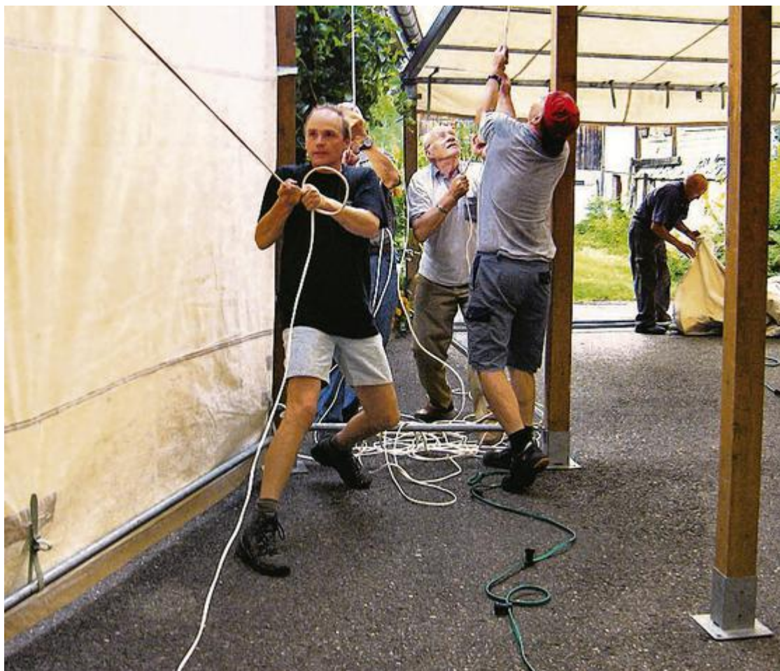
Die Helfer zeigen beim Bau des Festzeltes vollen Einsatz. (Bild: pd.)
